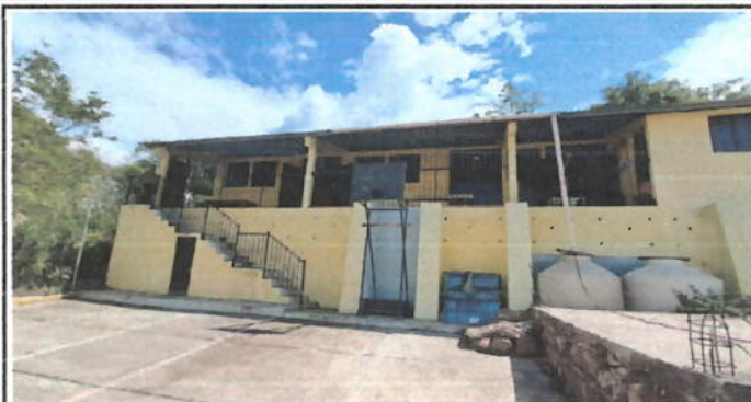
Foto1: PINTURA EN MUROS INTERIOR Y EXTERIOR Preparación de la superficie y aplicación de pintura , en paredes interiores y exteriores del establecimiento y retoque de logo
