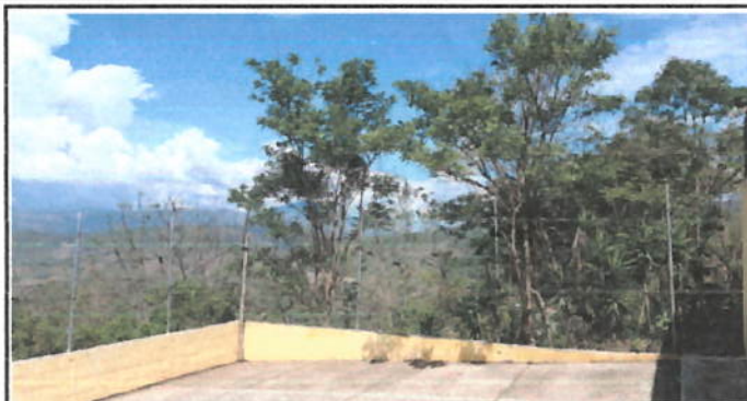
Foto 2: Sustitución malla de acero galvanizado en perímetro del establecimiento con instalación fija y tensa, anclajes metálicos en intervalos regulares.
