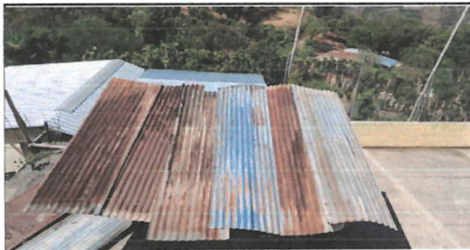
Foto 4: ESTRUCTURA DE TECHO Sustitución de estructura metálica para soporte de cubierta de lámina incluyendo perfiles para vigas, travesaños, sujeta con tornillería; corte,
