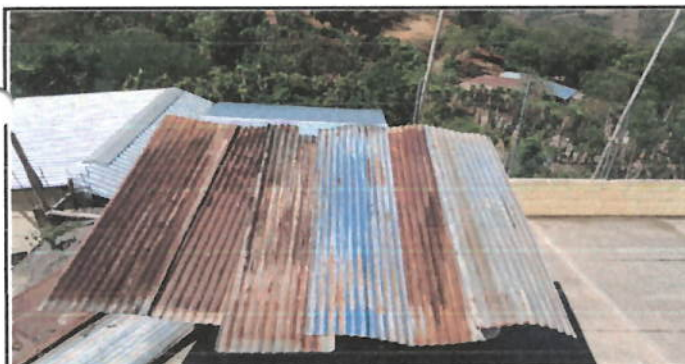
Foto 3: CUBIERTA DE LAMINA Sustitución de cubierta de techo con lámina galvanizada, Tipo de lamina: troquelada Calibre: 26, incluye: fijaciones y sellado en traslapes.
